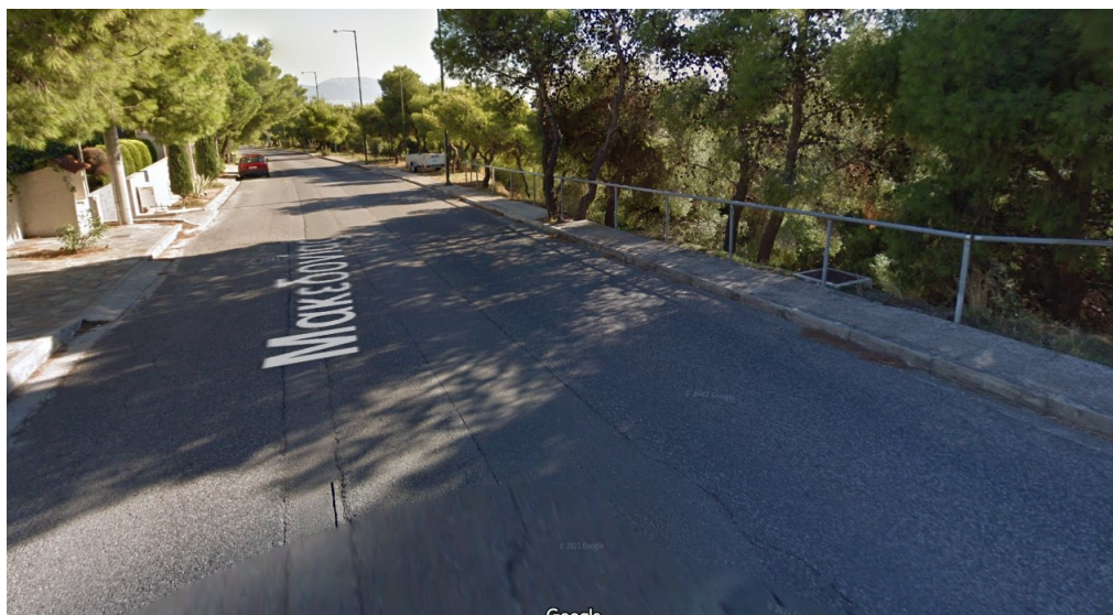
ΜΑΚΕΔΟΝΙΑΣ_ ΥΦΙΣΤΑΜΕΝΑ ΠΡΟΣΤΑΤΕΥΤΙΚΑ «Π» - ΠΡΟΤΑΣΗ ΓΙΑ ΑΝΤΙΚΑΤΑΣΤΑΣΗ ΜΕ ΣΤΗΘΑΙΑ ΠΗΓΗ: GOOGLE
